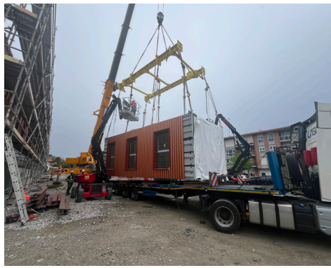
Montaje de las unidades según el orden de montaje preestablecido
