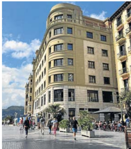
Estado actual del edificio de Ijentea 2 tras la rehabilitación integral a la que ha sido sometido para su transformación en 28 nuevas viviendas.
