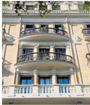
► Balcones curvos en el centro de la fachada a Okendo. Una unidad compositiva que agrupa tres alturas y ordena el alzado desde dentro.
