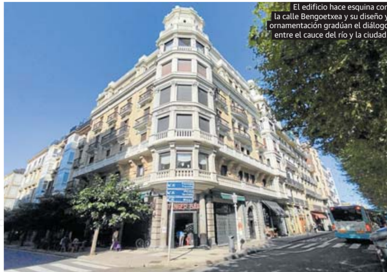
► Balcones curvos en el centro de la fachada a Okendo. Una unidad compositiva que agrupa tres alturas y ordena el alzado desde dentro.
