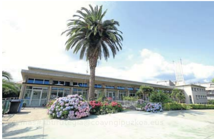
La guardería María Pilar Izquierdo, con sus costillas estructurales que se cierran con grandes vidrios. ARIZMENDI
