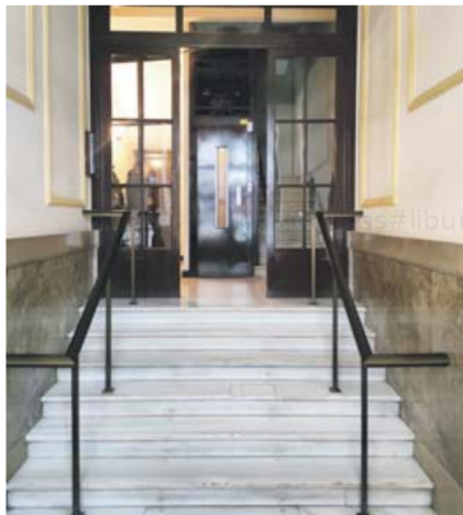
Sobre estas líneas, un portal antes y después de realizar una mejora en su accesibilidad.
