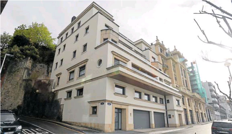
Vista del edificio de Miraconcha 28 con sus dos fachadas. GORKA ESTRADA
