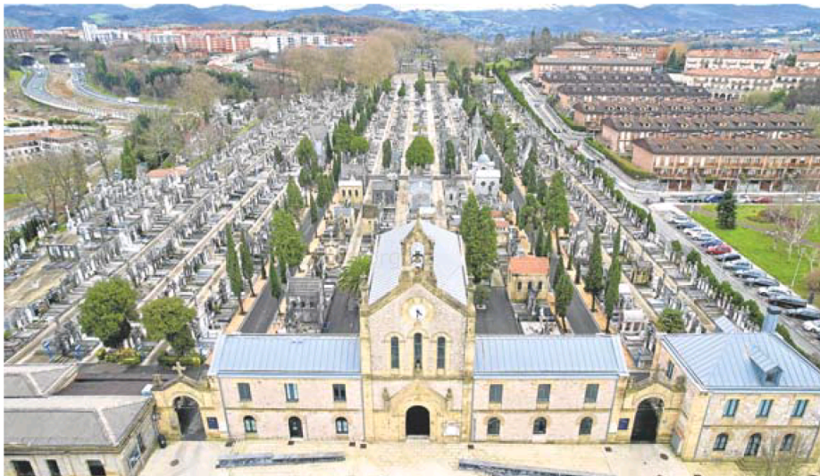
Trama ortogonal del cementerio de Polloe, ensalzada por las alineaciones de árboles, con el edificio cabecera y la capilla en primer plano. IMANOL SISTIAGA
