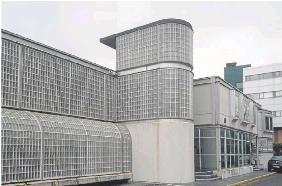
Imagen actual del almacén de la UFG, hoy Distribuidora Farmacéutica de Gipuzkoa, en el polígono de Igara. JONATHAN CHANCA
