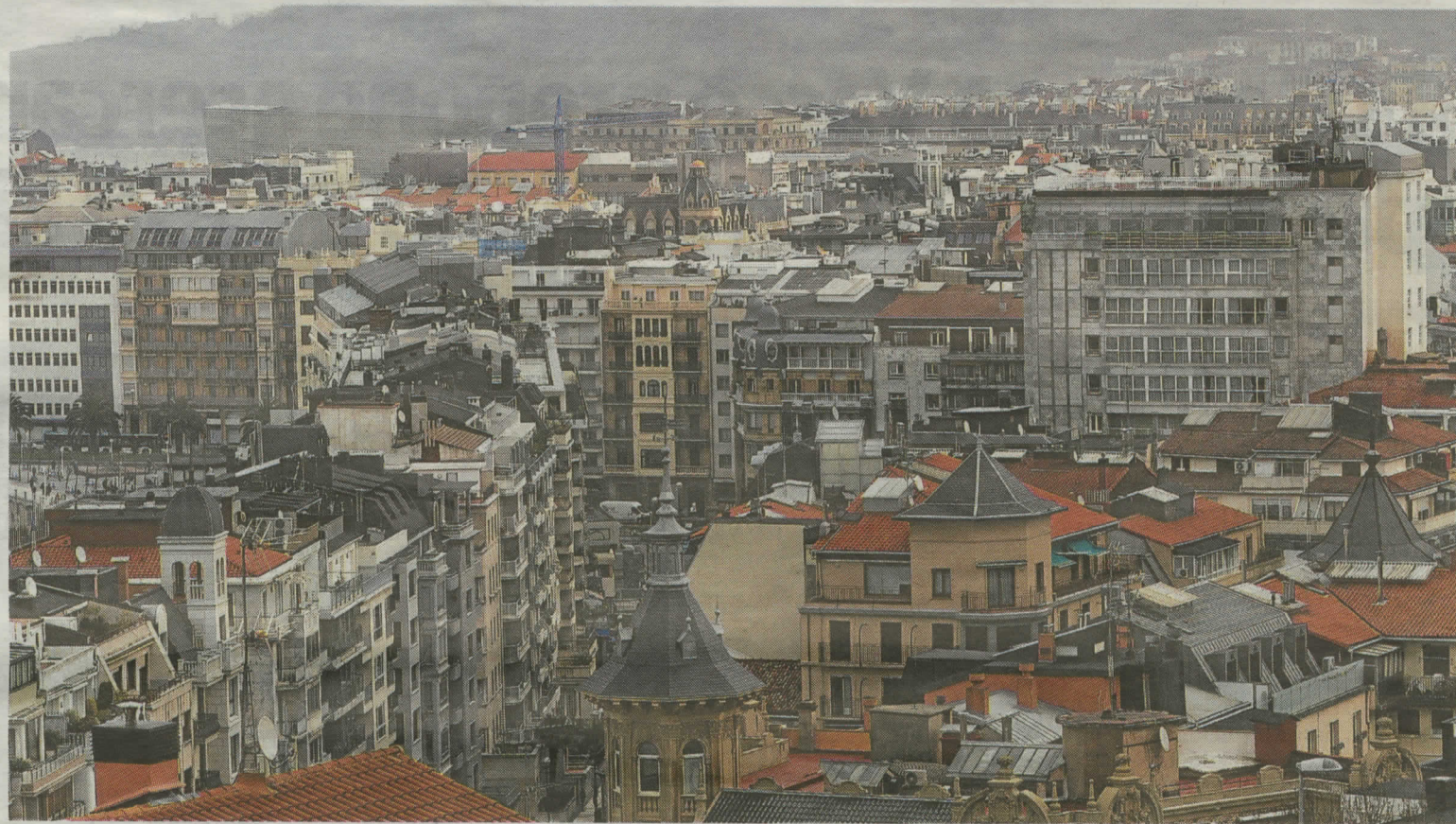
Vista del Centro de Donostia. La ITE es obligatoria para los edificios que tengan cincuenta años de antigüedad. :: SARA SANTOS
