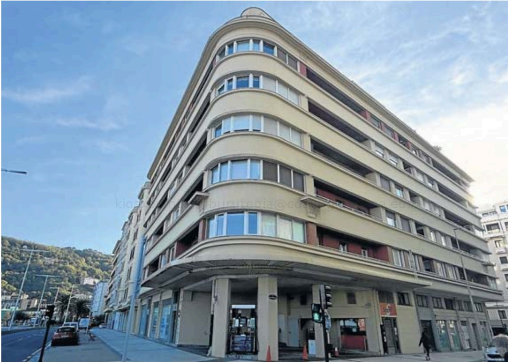
Fachada en esquina del edificio de Zurriola 32-34. E.F.N.
